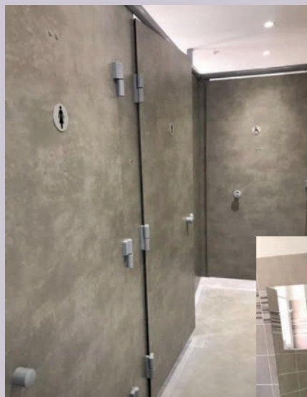
Fin de la rénovation du bloc sanitaire à la salle paroissiale
