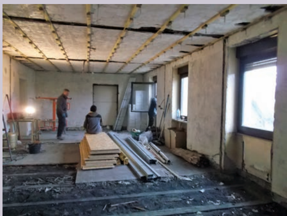
Rénovation d'un appartement 4, rue des écoles
